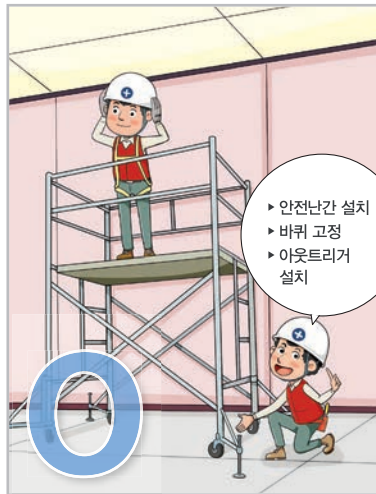
사업주는 이동식비계와 같은 안전한 작업발판을 지급해야 합니다.
